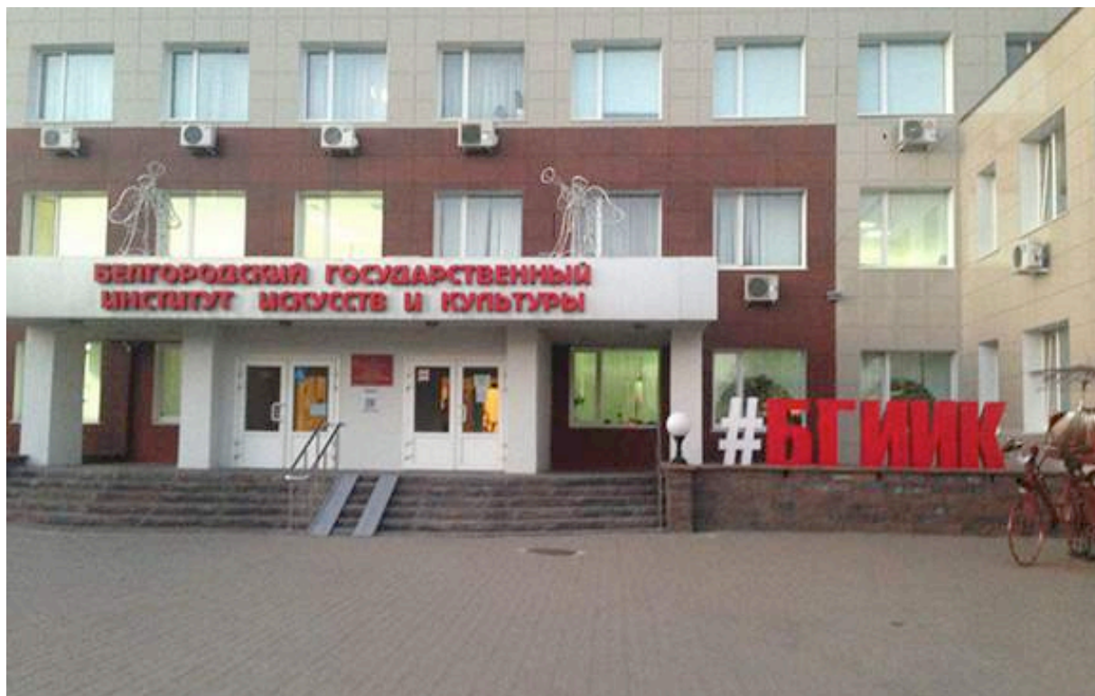
Рисунок 2.24 – Конструкция с хештегом на входе в здание Белгородского государственного института культуры и искусства
